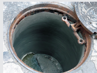
マンホール内施工完了
