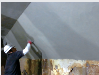
KS500 施工状況
