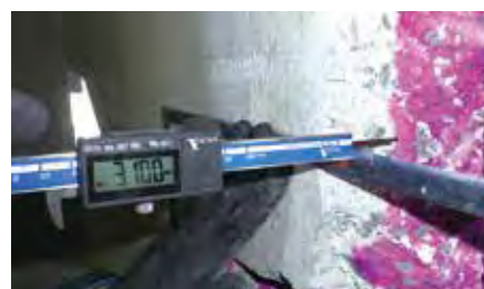
コンクリート躯体の中性化
