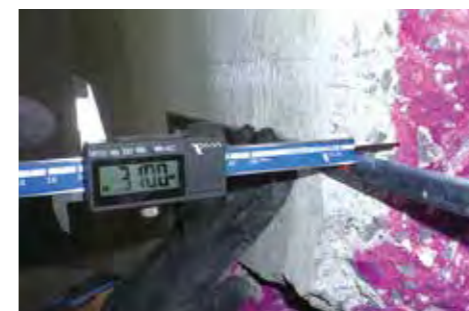
中性化深さ確認
