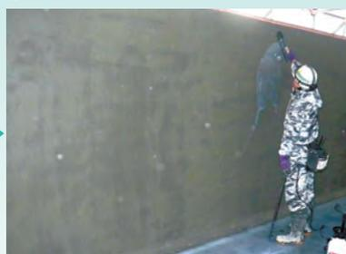
ジックFit-Aを散布、コテで平滑に仕上げる。
