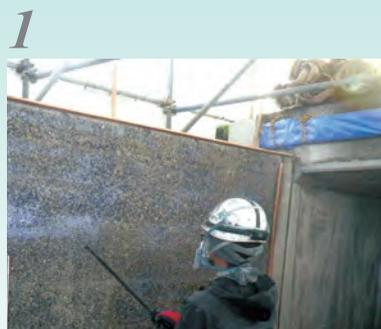
高圧水処理にてコンクリート表面の脆弱層を除去後、プライマーを噴霧器又はローラーにて均一に塗布する。
