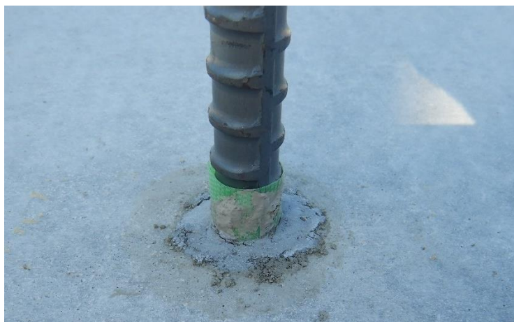
写真 4-19 セメントの濡れ色がなくなったロックフィルボンド
