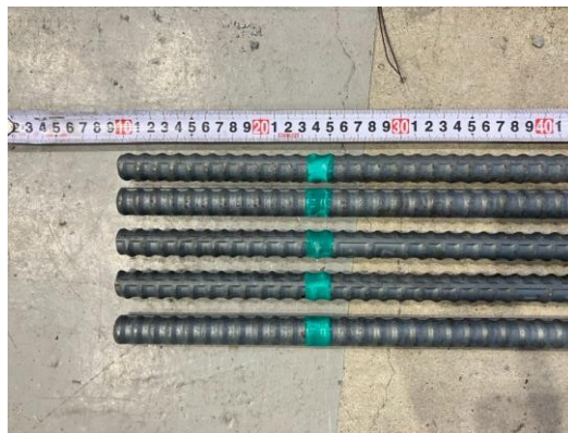
写真 4-5 アンカー筋へのマーキング (埋込み長さの位置)
