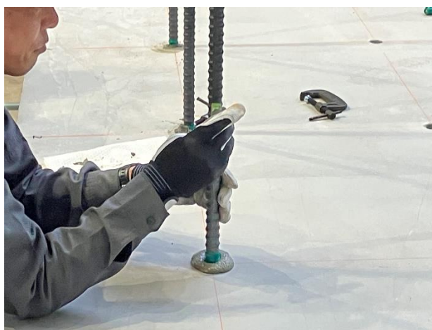
写真 4-17 アンカー筋の埋込み
