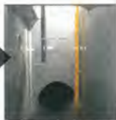
防食被覆工完了事例
