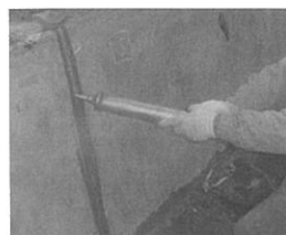
目地への施工状況
