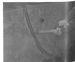
ひび割れへの施工状況
